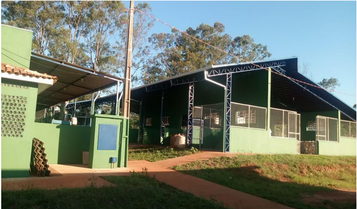
Figura 4. Novo Barracão em funcionamento em outubro de 2018.
