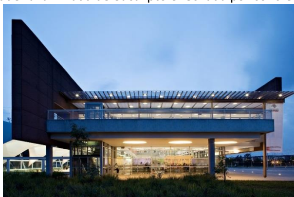
Figura 5. Terraço feito de madeira laminada de eucalipto e fechada por concreto texturizado
