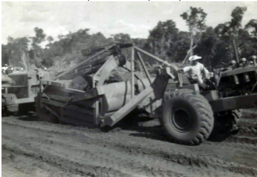
Figura 1. Abertura do ramal de Dourados no pontal do Paranapanema pela CBPO
