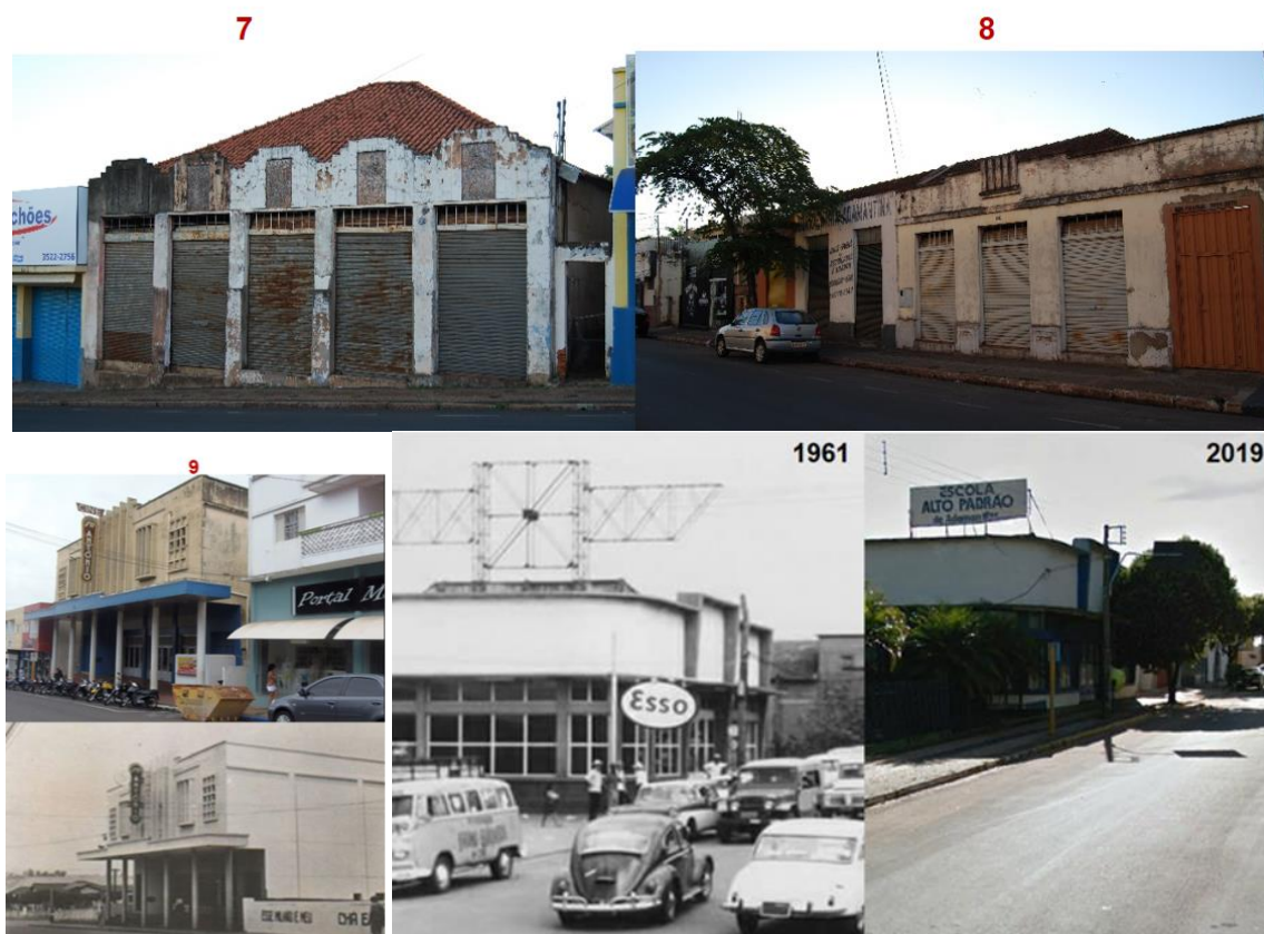
Figura 6. Edificações que foram mantidas
