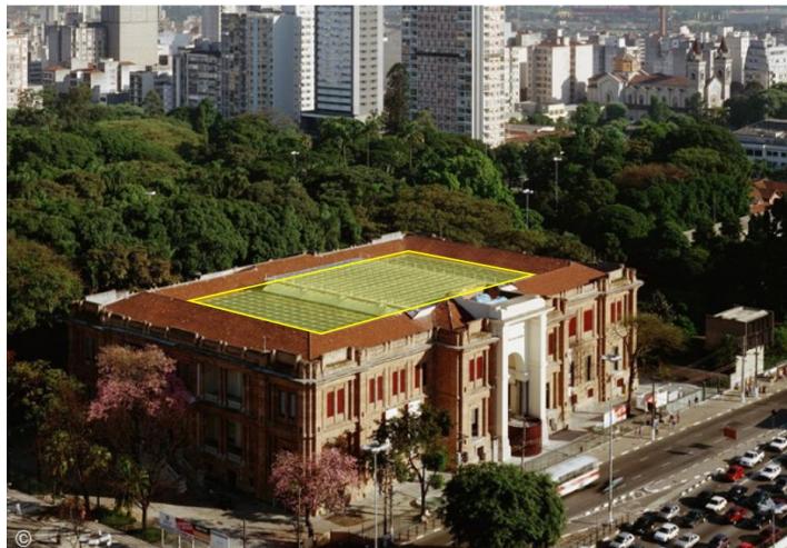
Figura 1. Novo Cobertura Adiciona ao Edifício
