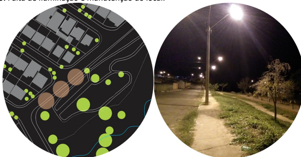
Figura 5. Falta de iluminação e manutenção do local.
