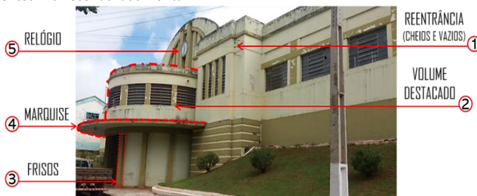
Figura 4. Elementos Art Deco fachada frontal
