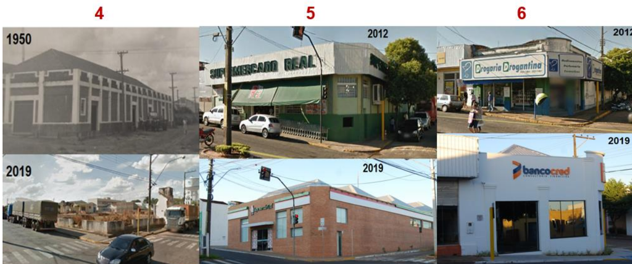
Figura 5. Edificações que sofreram modificações permanentes
