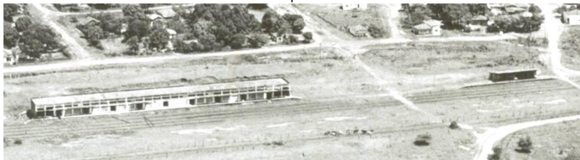
Figura 3. Edifícios desativados no ramal de Teodoro Sampaio
