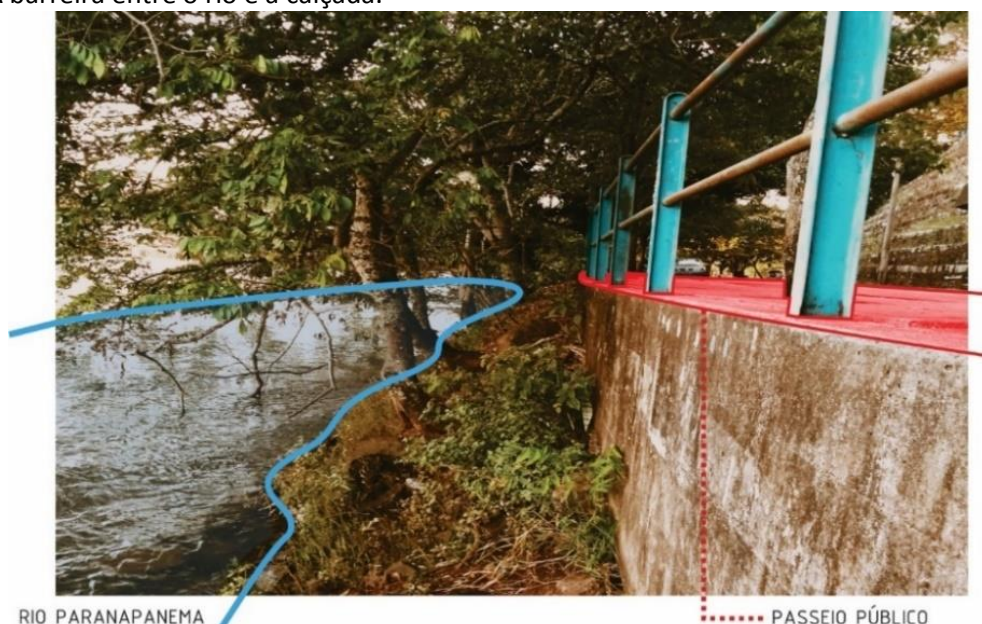
Figura 06. A barreira entre o rio e a calçada.
