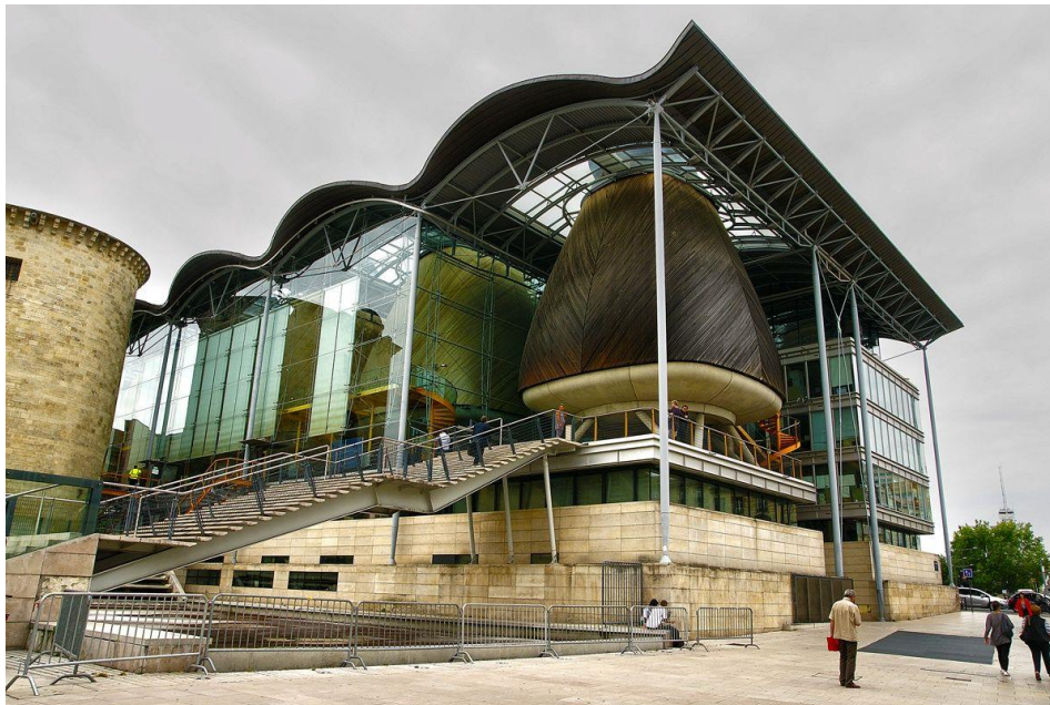
Figura2. detalhe do edifício Law Courts Boudeaux.
