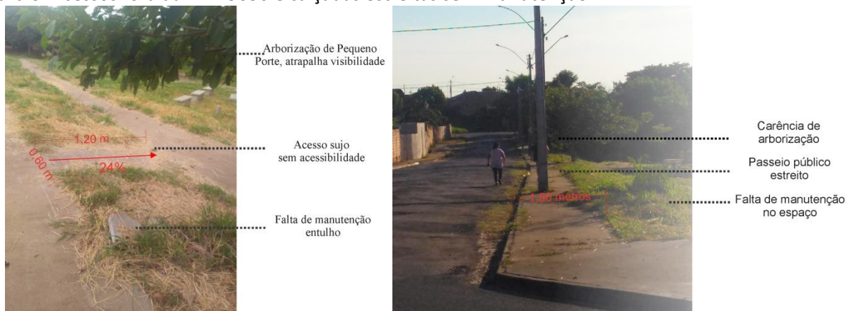
Figura 6. Acessos fora da NBR 9050 e calçadas estreitas sem manutenção.
